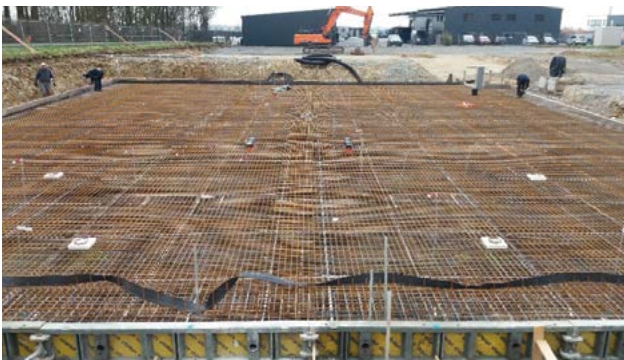
> Bild 12a: Beispiel für Darstellung der Teile der Erdungsanlage aus unterschiedlichen Blickwinkeln – Ansicht 1
