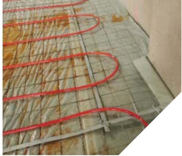
> Bild 5: Nutzung von Bewehrungsmatten zur Lagefixierung der Fußbodenheizung als kombinierte Potentialausgleichsanlage bei nicht leitfähig bewehrter Bodenplatte
